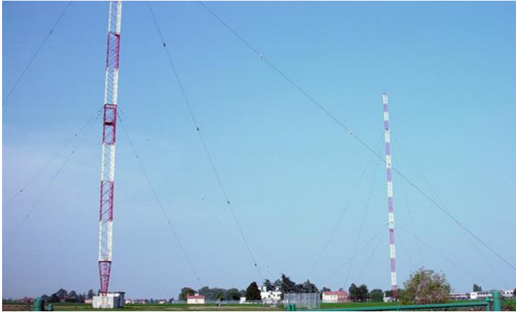
Fig. 14 - Antenna onde medie RAI1 di Budrio (BO)
